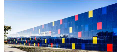
PVT – Strom und Wärme aus Fassade
