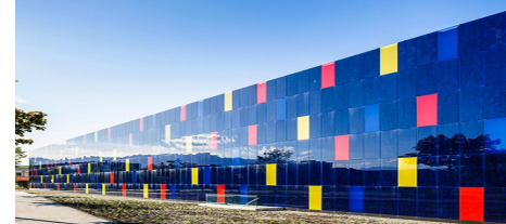
PVT – Strom und Wärme aus Fassade
