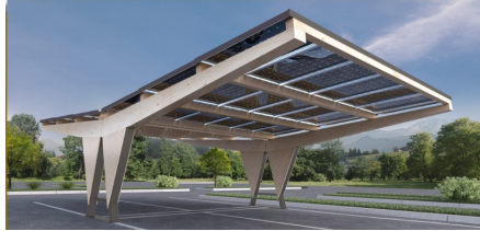
PV über Park- und Ladeplätzen
